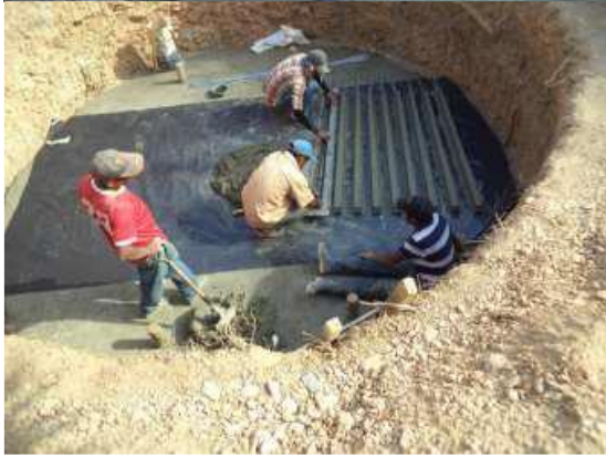
Miembros de las familias beneficiarias, participando en el proceso de excavación de la fosa de 5 metros de diámetro y 1.5 metros de profundidad, así como las primeras fases de construcción de la cisterna de 25.000 litros
