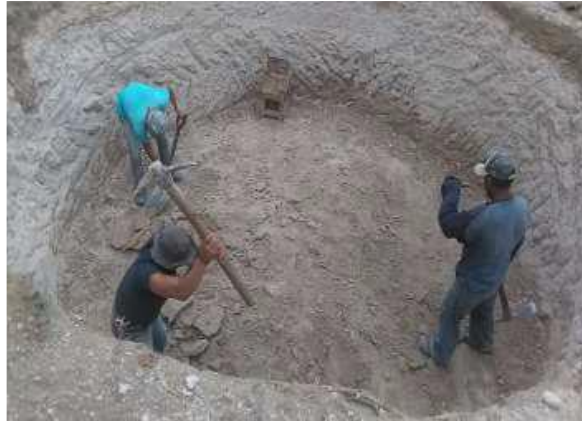
Miembros de las familias beneficiarias, participando en el proceso de excavación de la fosa de 5 metros de diámetro y 1.5 metros de profundidad, así como las primeras fases de construcción de la cisterna de 25.000 litros
